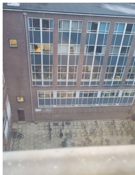
図 1: 窓から見る工学部棟です
