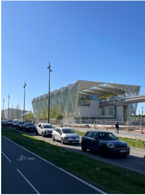
写真左: 新しいメトロ 18 番線の駅。
